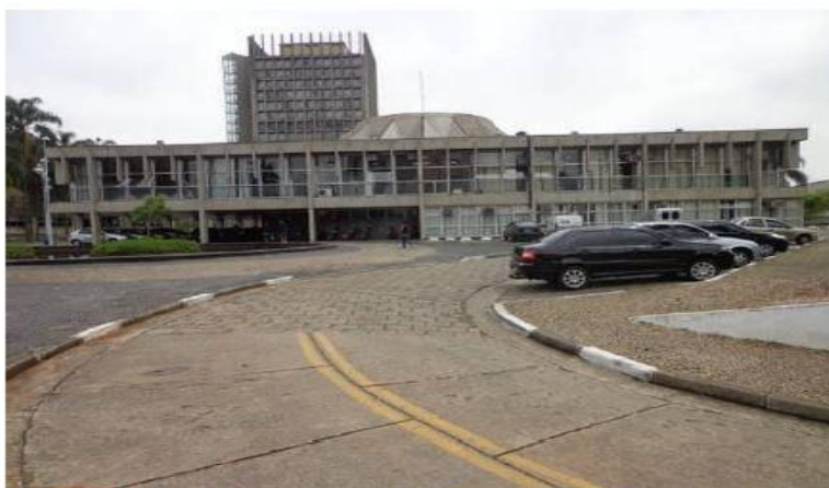
Foto 02 – Vista geral da fachada posterior do edifício da Câmara (região do lago).
