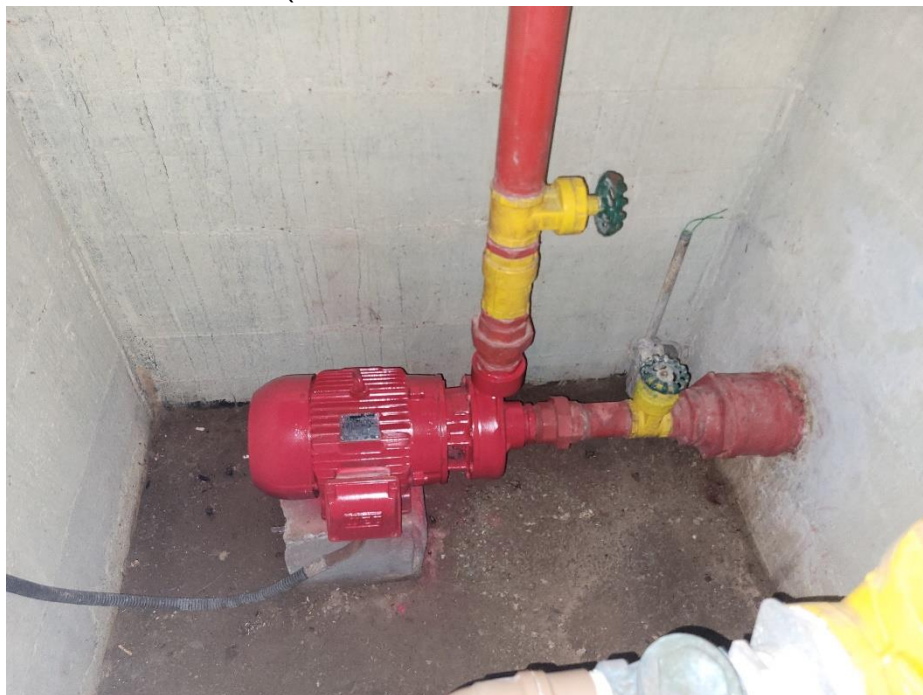
BOMBA DE INCÊNDIO (AO LADO DO RESERVATÓRIO SUBTERRÂNEO)
