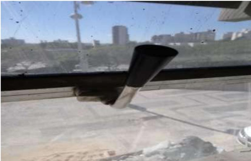
13.4.4. Foto da haste vertical com insumo, ambos em aço inox, fixados com parafusos de inox, considerar dois lados na janela intermediária.
