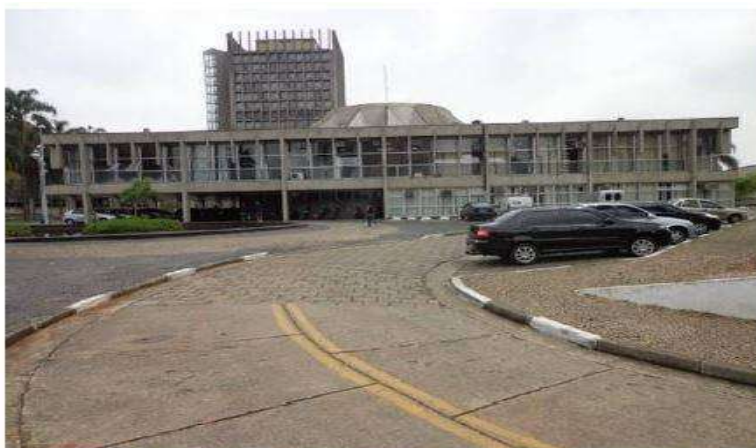
Foto 02 – Vista geral da fachada posterior do edifício da Câmara (região do lago).
